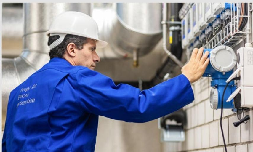
Die Ultraschall-Clamp-on-Durchflussmessgeräte **Proline Prosonic Flow W 400 und P 500** ermöglichen eine bequeme Bedienung vor Ort über das Gerätedisplay sowie den vollständigen Fernzugriff über den eingebauten Web-server.
