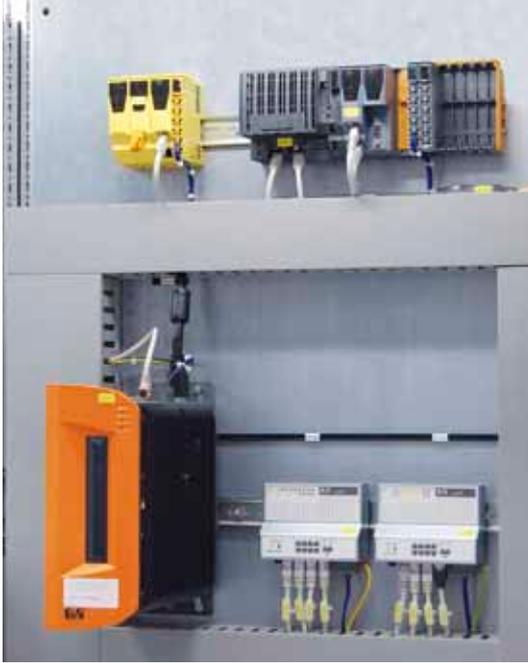
Über POWERLINK verbunden mit einer zentralen Safety CPU überwachen Safety I/O Module an acht X20 Knoten die Anlage. Der Entfall der diskreten Verkabelung beschleunigt die Inbetriebnahme, umfangreiche Diagnosemöglichkeiten erhöhen die Reaktionsfähigkeit im Fehlerfall.
