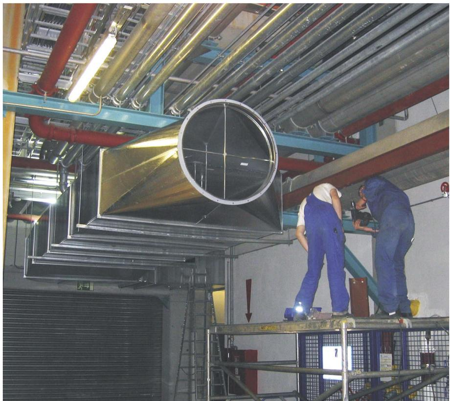
Lüftungsanlage in einer Papierfabrik, gut eingebettet in eine dichte Verrohrung
